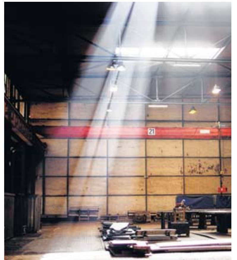
In der Halle in Benrath werden die Hafemobilkrane in drei getrennten Teilen gefertigt. Zusammengebaut werden sie erst vor Ort.
